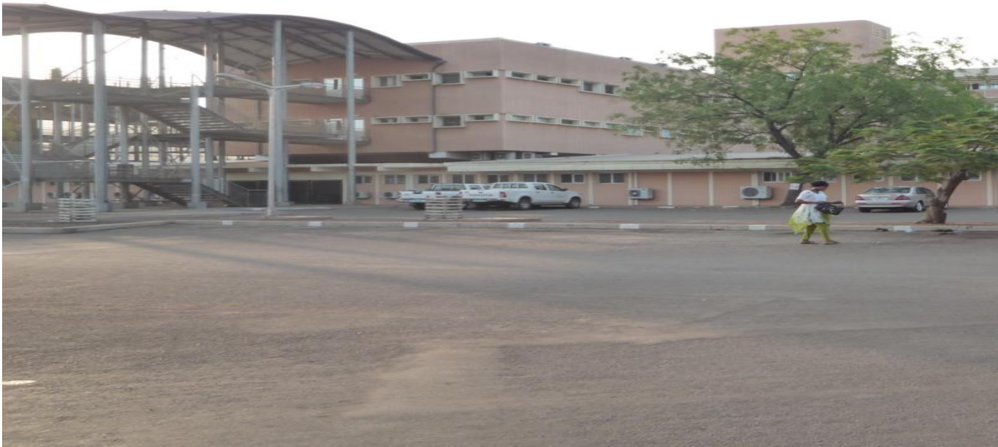
Blik op de kantoorafdeling en de gerenoveerde poliklinieken gezien vanaf siteoffice.
