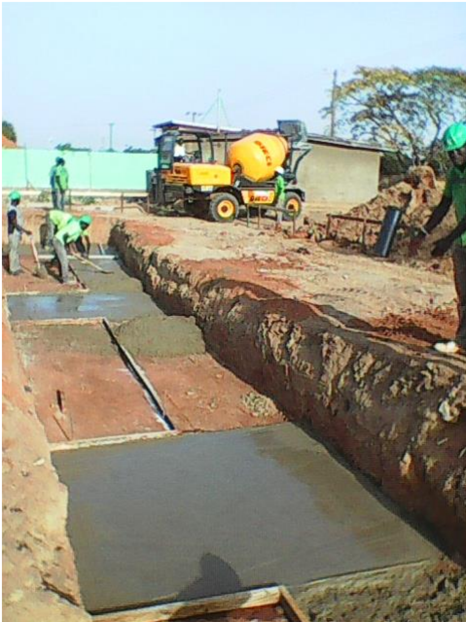
De mixer op de achtergrond maakt / mengt zelf de betonmortel op recept!
